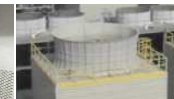
冷卻水塔汰換
