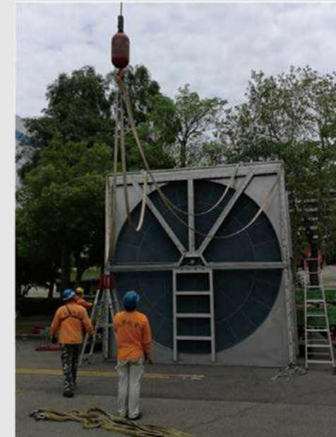
沸石轉輪汰舊換新工程
